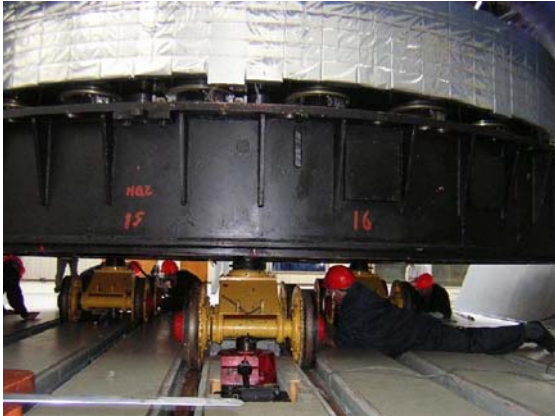
Рис. 11. Демонтаж Главного зеркала БТА. Fig. 11. Dismantling the BTA main mirror.
