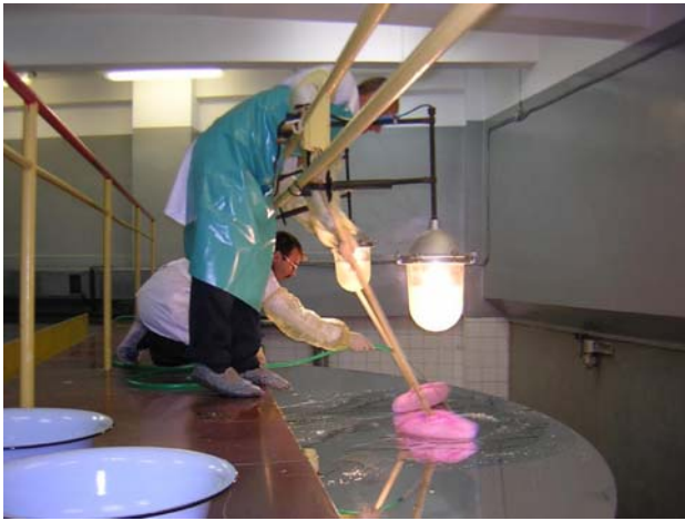
Рис. 12. Снятие старого алюминиевого слоя. Fig. 12. Removal of the old aluminium layer
